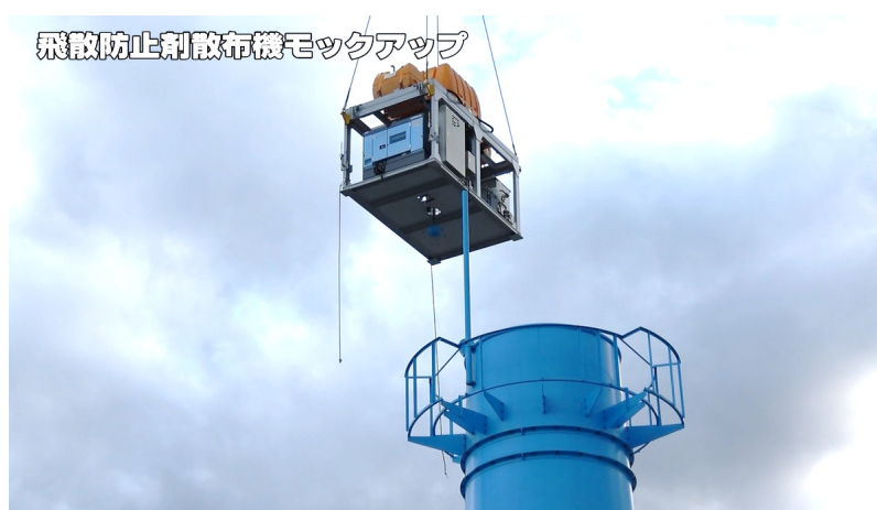
飛散防止剤散布装置据付
