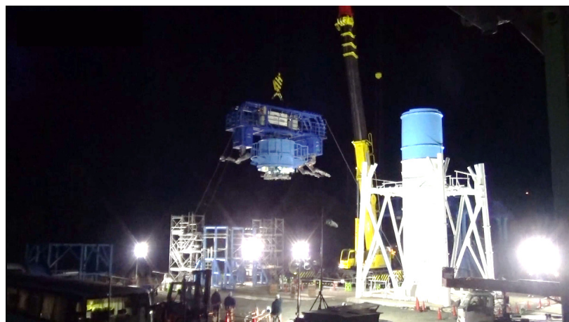
筒身切断作業状況(夜間)
