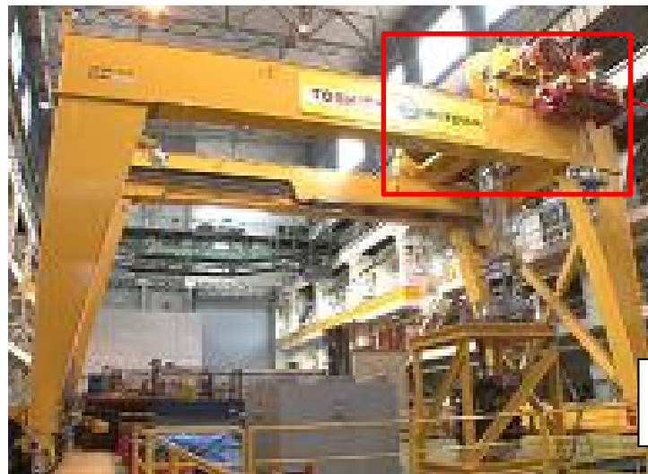
クレーン全景
