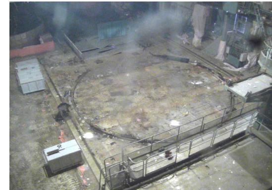
① 残置物片付後（ウエル上）撮影日(11/6)
