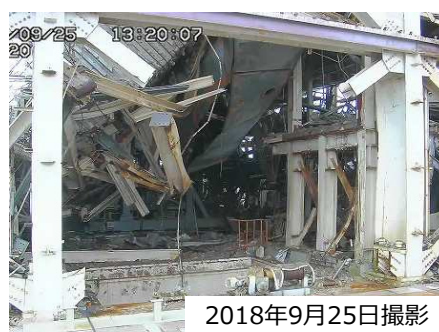
西面Xブレース撤去後
