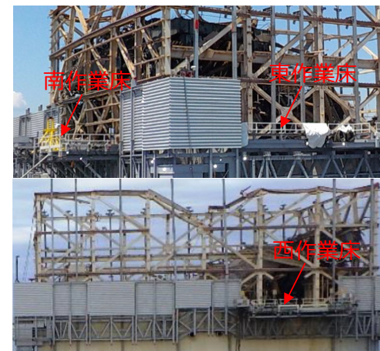
東・南・西作業床の状況
