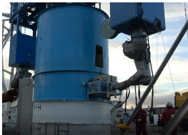
筒身外周切断状況
