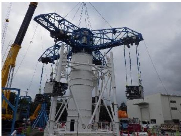
主柱材解体状況
