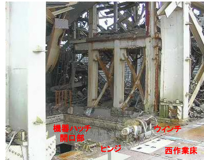
機器ハッチの状況（西作業床より）
