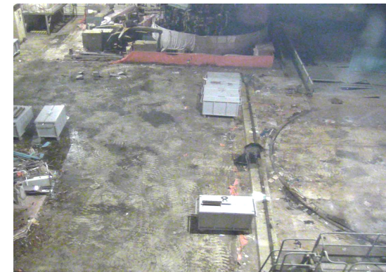
② 残置物片付後（北側）撮影日(11/6)
