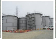
タンクの設置状況
