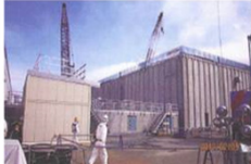
廃スラッジ一時保管施設
