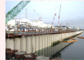
海側遮水壁 鋼管矢板打設完了状況
