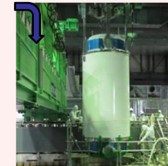
燃料取り出し状況
