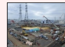
H1東エリア解体後の様子
