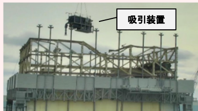
<進捗状況(1/22撮影)>
