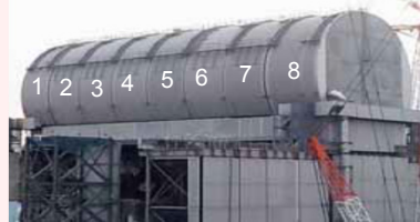
ドーム屋根設置状況 (2/21撮影)
