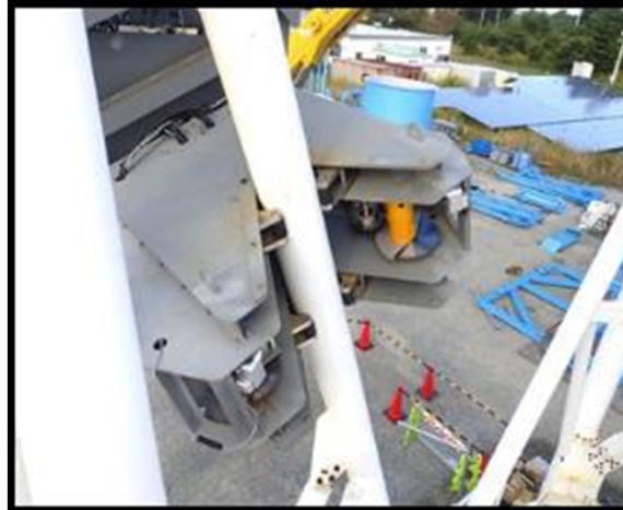
斜材切断装置切断状況
