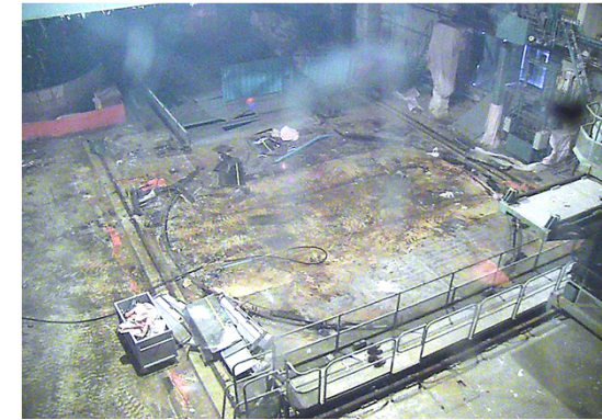
①残置物片付後 (ウエル上) 撮影日(10/22)
