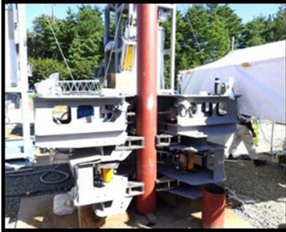
支柱切断装置切断状況
