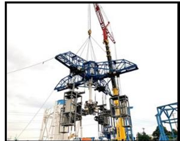
クロスハンガー吊り上げ状況
