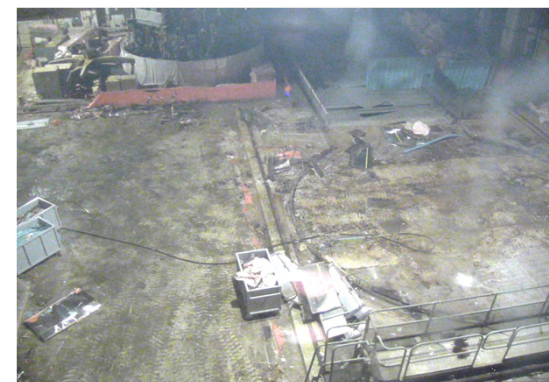
②残置物片付後 (北側) 撮影日(10/22)
