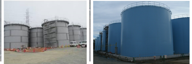
タンクの設置状況
