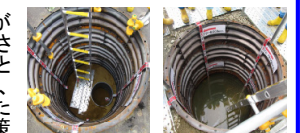
(陸側遮水壁) 内側 (陸側遮水壁) 外側
