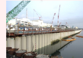
海側遮水壁 鋼管矢板打設完了状況
