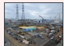
H1東エリア解体後の様子
