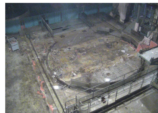
①残置物片付後 (ウエル上) 撮影日(9/21)
