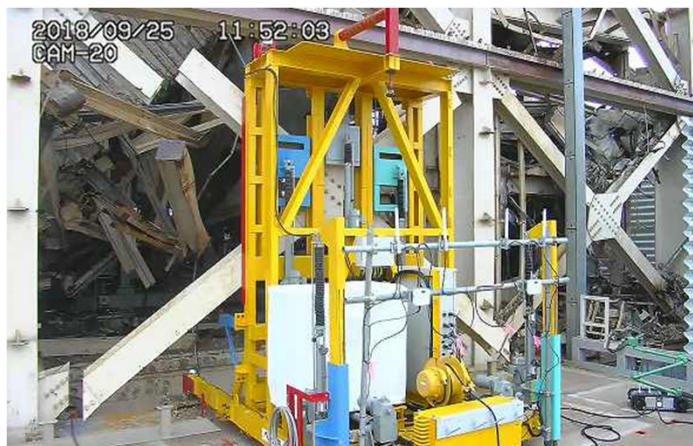
把持装置でのXブレース引き抜き
