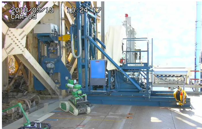
バンドソーでのXブレース切断
