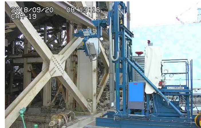
セーバーソーでのXブレース切断
