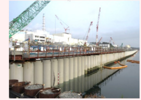
海側遮水壁 鋼管矢板打設完了状況
