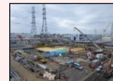
H1東エリア解体後の様子
