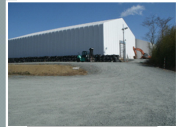
瓦礫保管テント
