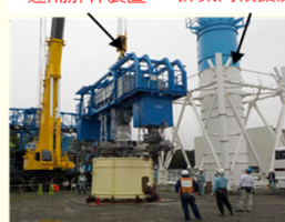
モックアップ試験の状況
