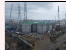
H1東エリア解体開始時の様子
