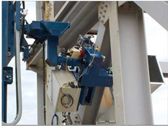
セーバーソーによる切断
