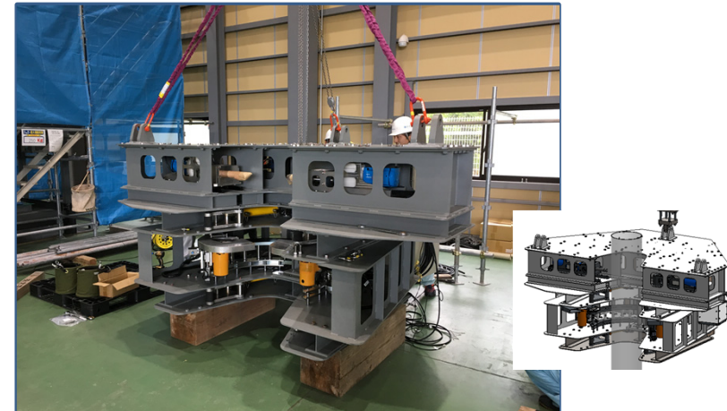
鉄塔解体装置（主柱材用）組立状況
