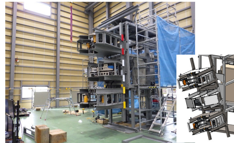
鉄塔解体装置（斜材用）組立状況
