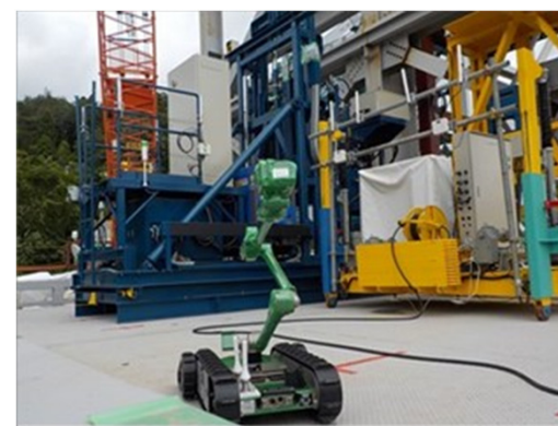
小型ロボットによる監視
