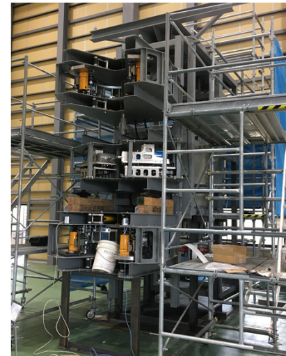
鉄塔解体装置（斜材用）組立状況
