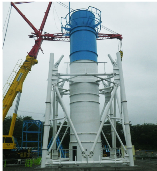
試験体 設置作業状況 (6/15時点)
