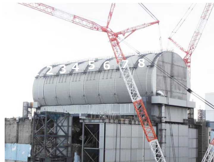
ドーム屋根設置完了
