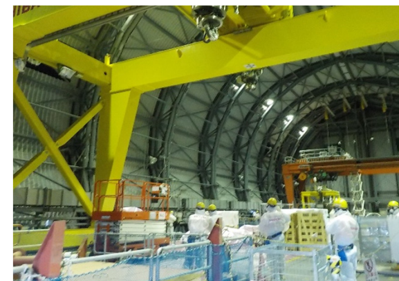
3号機原子炉建屋オペフロ 試運転状況
