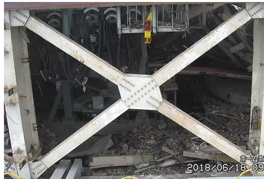
2018年6月 (支障物撤去着手後)
