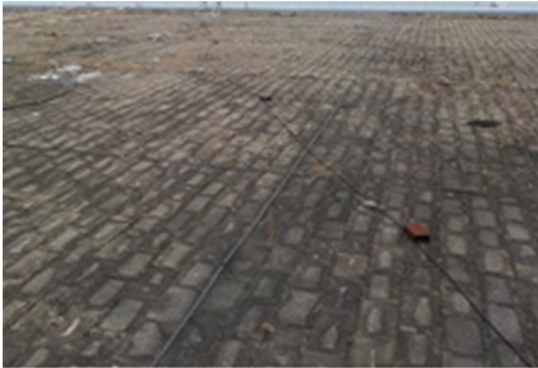
①作業前状況
