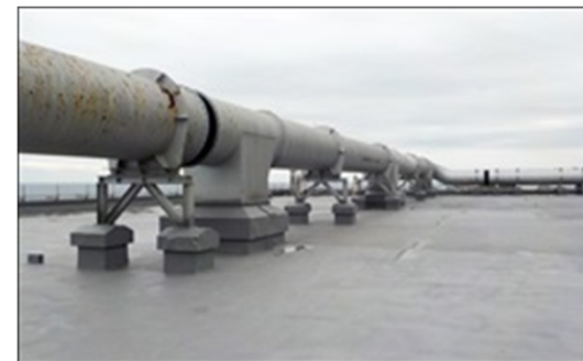
【現況】4号機T/B屋上 (本設防水完了)
