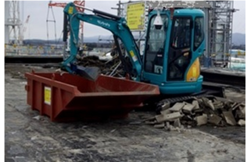
②遠隔重機によるルーフブロック・砂撤去状況
