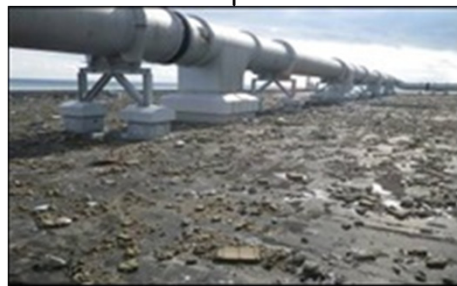
【施工前】4号機T/B屋
