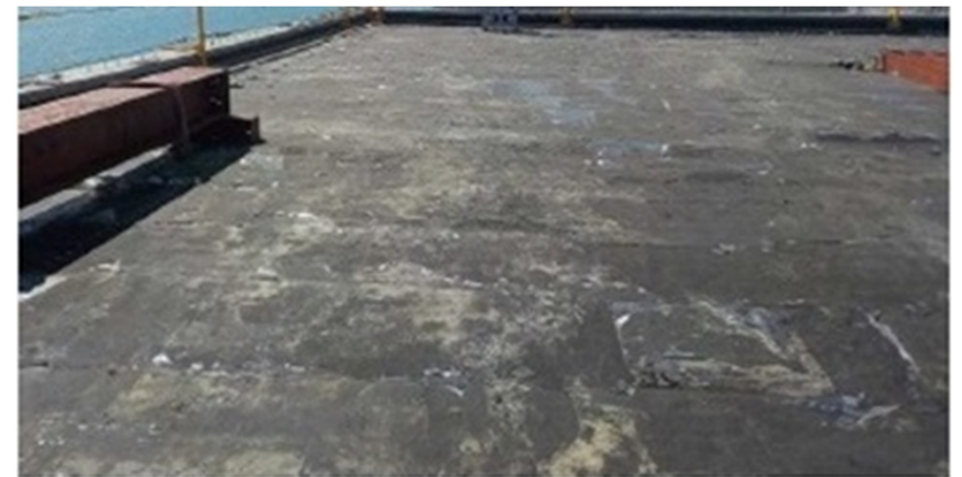
④作業完了状況
