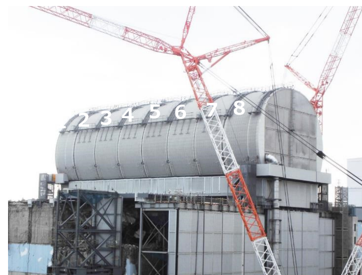
ドーム屋根設置完了
