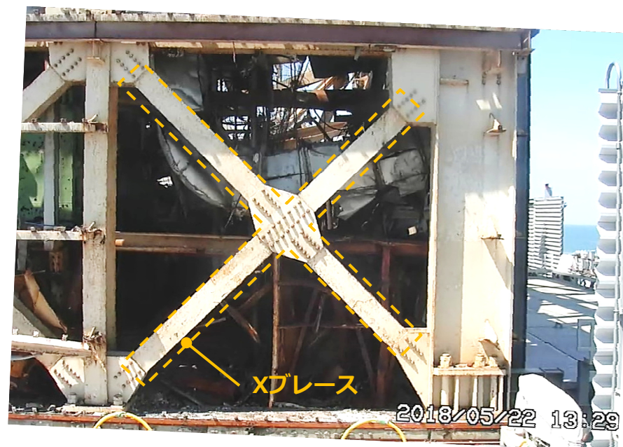
2018年5月 (支障物撤去着手後)
