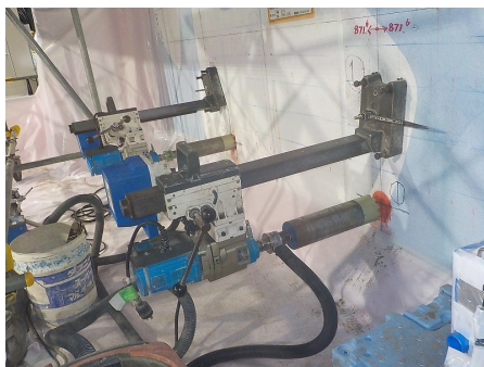
コア削孔装置設置状況
