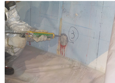
削孔箇所の孔塞ぎの状況
