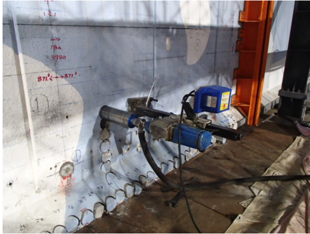
解体用コア削孔（STEP3） 2018/4/24撮影
