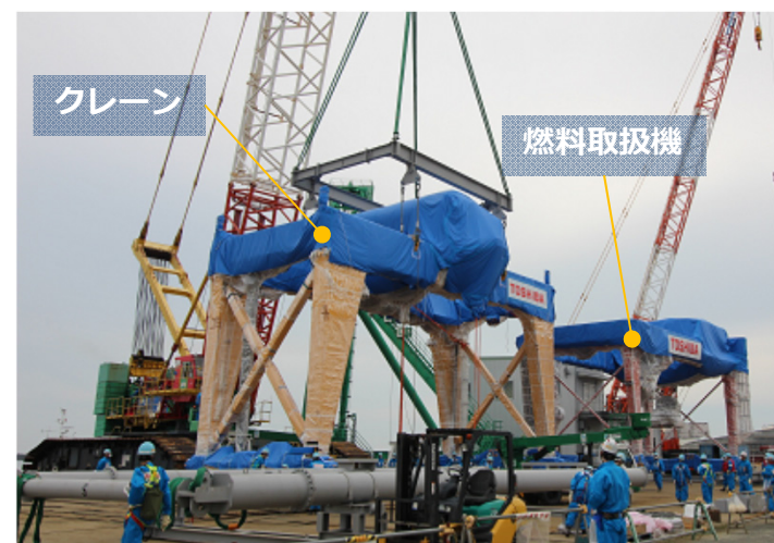
燃料取扱機・クレーンの海上から構内に搬入状況 (撮影日2017年11月8日)
