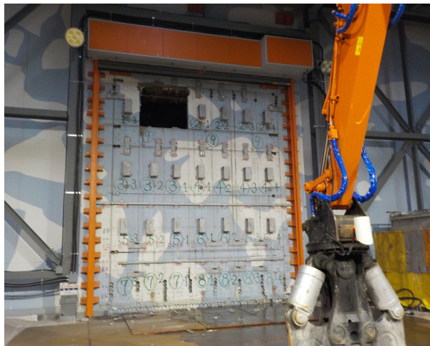
壁解体(STEP6) 2018/5/28撮影
