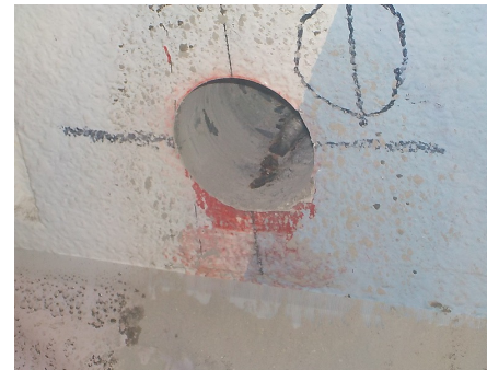
コアを削孔した状況
