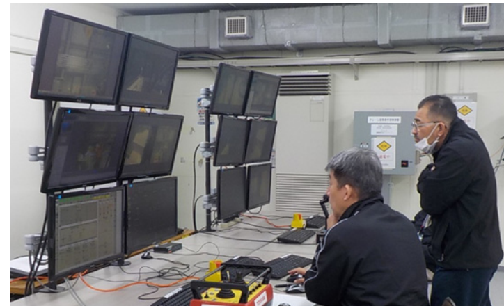
試運転実施状況（遠隔操作室）
