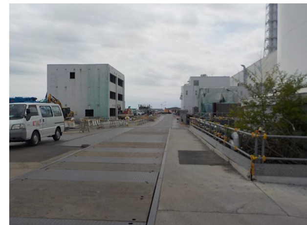
3号機海側道路
