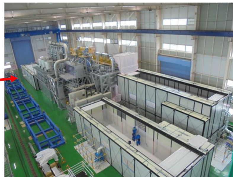
大型機器除染設備外観
