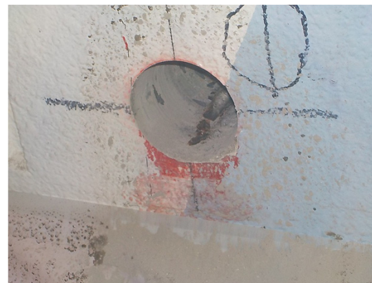
調査用コア採取の状況
