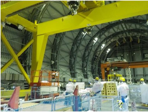
3号機原子炉建屋オペフロ 試運転状況
