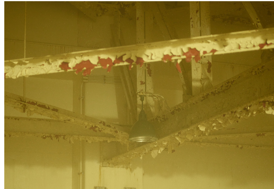
屋根鉄骨トラスと付属設備の状況
