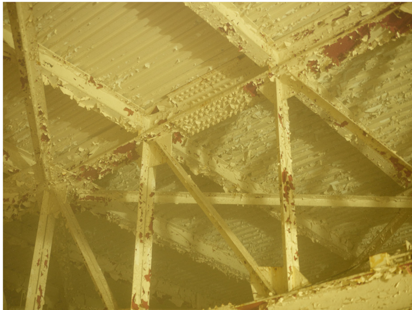
屋根鉄骨トラスと屋根スラブの状況
