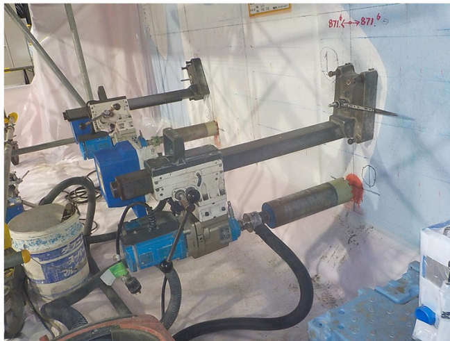
コア削孔装置設置状況
