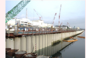
海側遮水壁 鋼管矢板打設完了状況
