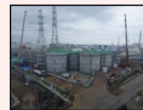
H1東エリア解体開始時の様子
