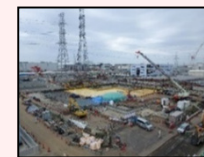
H1東エリア解体後の様子
