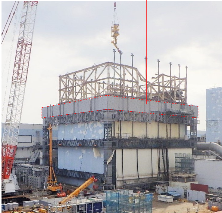
防風フェンス取付状況 撮影：H30.2.28
