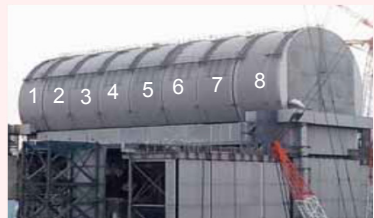
ドーム屋根設置状況 (2/21撮影)
