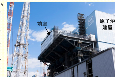
原子炉建屋西側の状況
