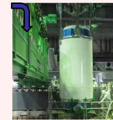
燃料取り出し状況
