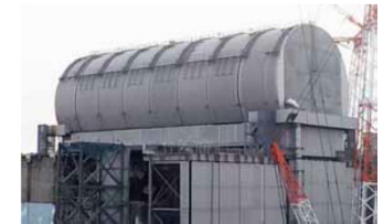
ドーム屋根設置状況 (撮影日2018年2月21日)
