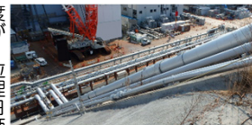
ブライン配管の設置状況
