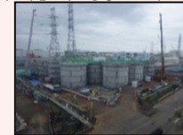
H1東エリア解体開始時の様子
