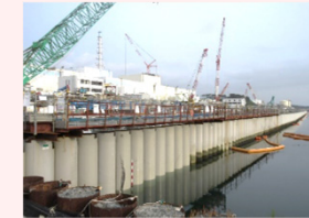
海側遮水壁 鋼管矢板打設完了状況
