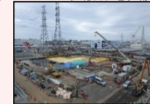
H1東エリア解体後の様子
