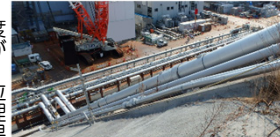
(ライン配管の設置状況)
