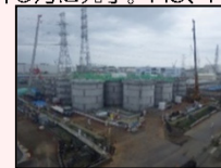
H1東エリア解体開始時の様子
