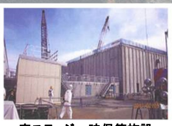
廃スラッジ一時保管施設
