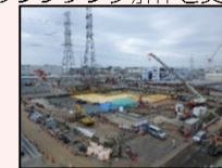
H1東エリア解体後の様子
