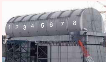
ドーム屋根設置状況 (2/21撮影)
