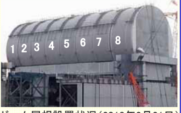
ドーム屋根設置状況（2018年2月21日）
