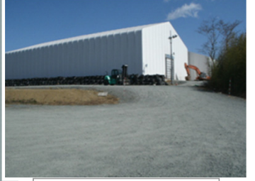
瓦礫保管テント
