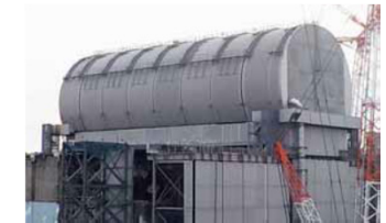
ドーム屋根設置状況 (撮影日2018年2月21日)
