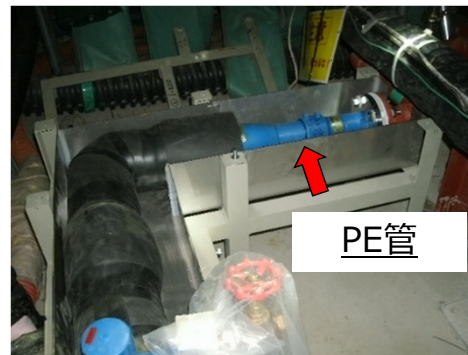
新規PE管施工後
