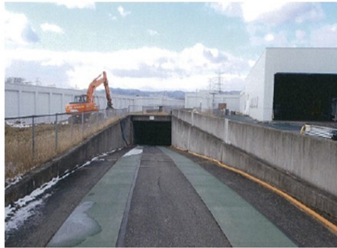
地下貯蔵庫入口斜路
