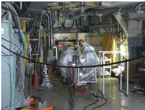
PCV外部（X-6ペネ）前での作業
