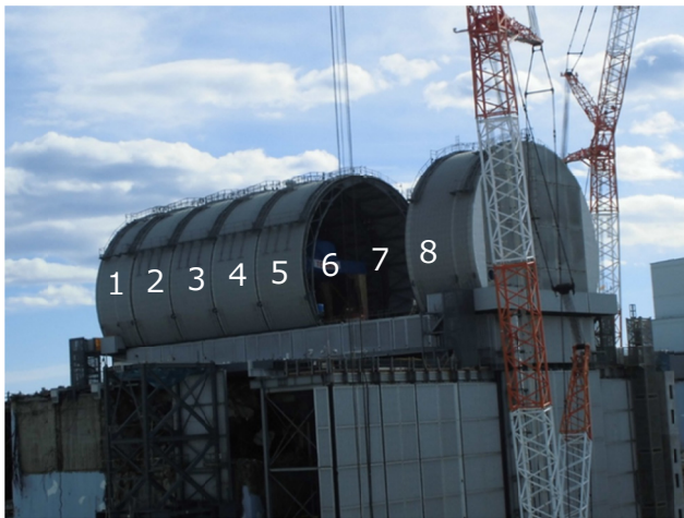
3号機原子炉建屋オペフロ全景
