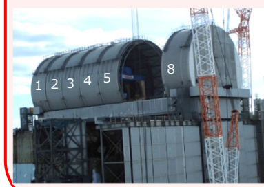
ドーム屋根設置状況(12/19撮影)
