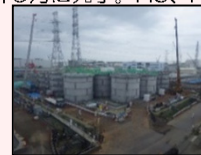
H1東エリア解体開始時の様子
