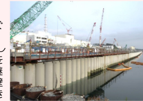
海側遮水壁 鋼管矢板打設完了状況
