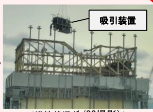
<進捗状況(1/22撮影)>
