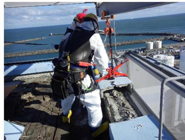
屋上での笠木撤去状況
