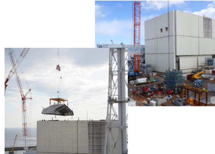
② 【2015年10月5日：屋根パネル取り外し完了】
