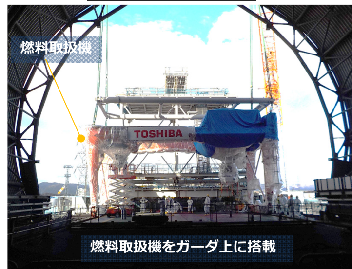
燃料取扱機・クレーンの海上から構内に搬入状況 (撮影日2017年11月8日)
