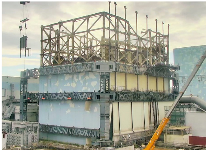
⑦ 【2017年10月31日：防風フェンス1枚目取り付け】
