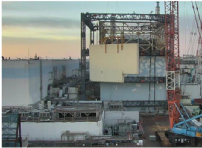
⑤ 【2016年11月10日：壁パネル取り外し完了】
