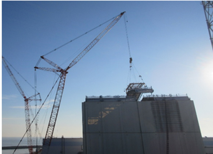
① 【2015年7月28日：屋根パネル1枚目取り外し】
