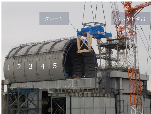
3号機原子炉建屋オペフロ全景
