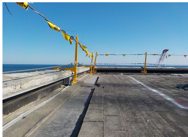
笠木等撤去後の手摺り設置状況
