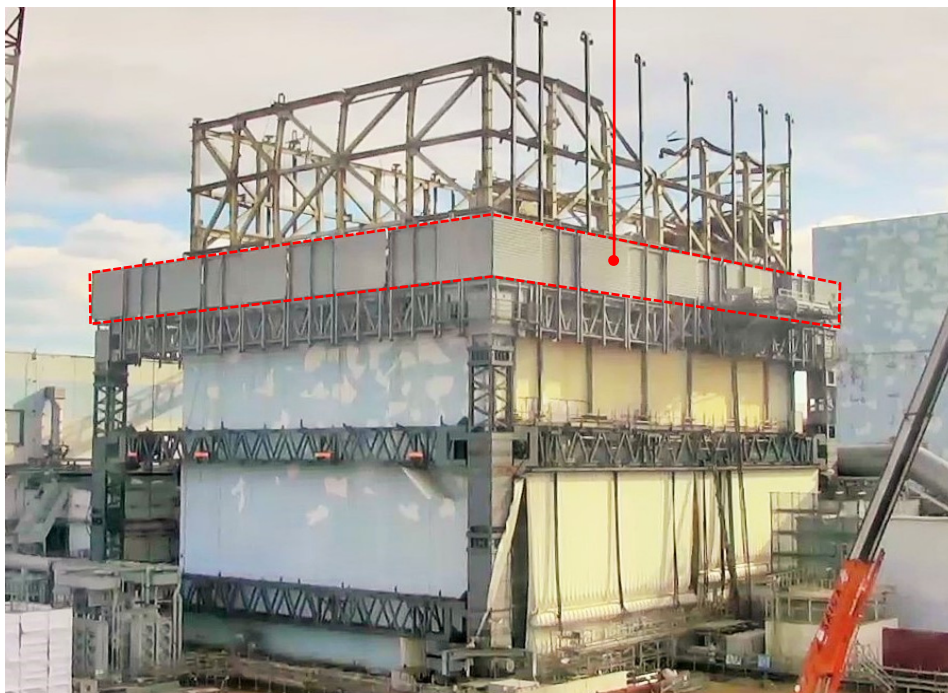
防風フェンス取付状況 撮影：H29.12.19
