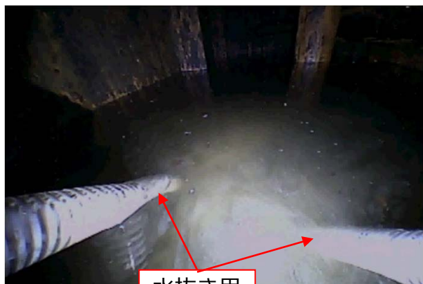
水抜き用のホース
