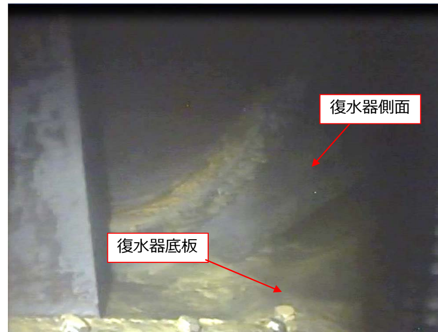
水抜き後の復水器底板の状況確認 (視線方向②)
