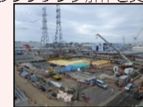
H1東エリア解体後の様子
