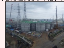
H1東エリア解体開始時の様子
