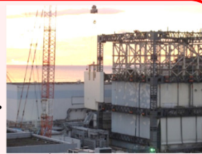
<壁パネル取り外し状況>
