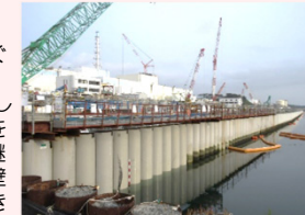
海側遮水壁 鋼管矢板打設完了状況
