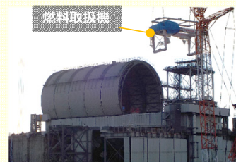
燃料取扱機の設置状況（撮影日2017年11月12日）
