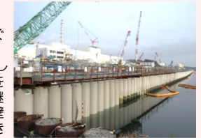
海側遮水壁 鋼管矢板打設完了状況
