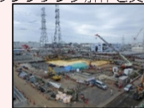
H1東エリア解体後の様子
