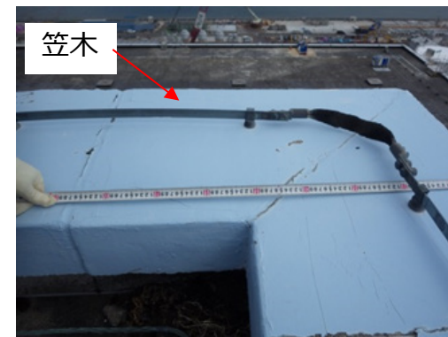
屋上外周部の状況（その2）
