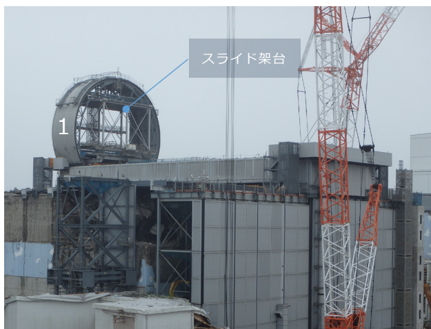
3号機原子炉建屋オペフロ全景 (8月5日時点)
