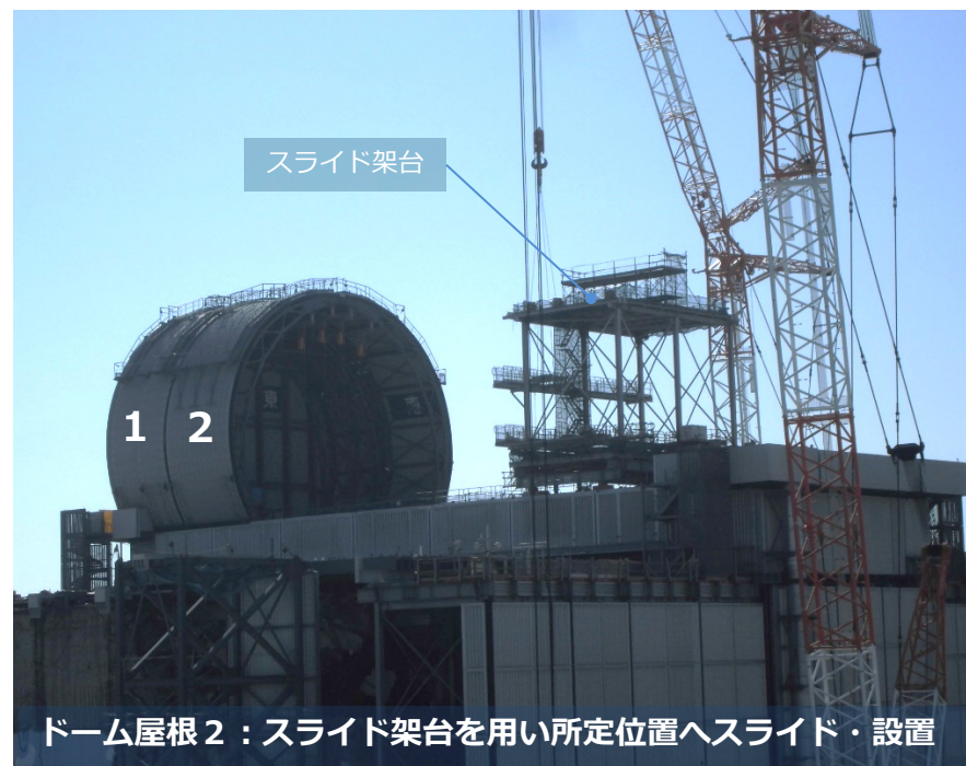
ドーム屋根設置状況 (撮影日：2017年9月26日)
