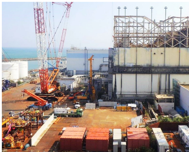
工事エリア全景 撮影：H29.9.25
