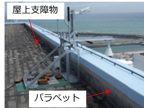
屋上外周部の状況（その1）
