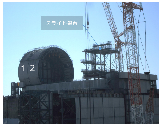
3号機原子炉建屋オペフロ全景 (9月26日時点)
