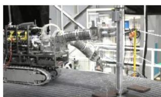
クレーン部品(支柱)設置状況
