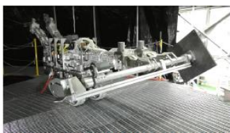
クレーン部品運搬状況(支柱)
