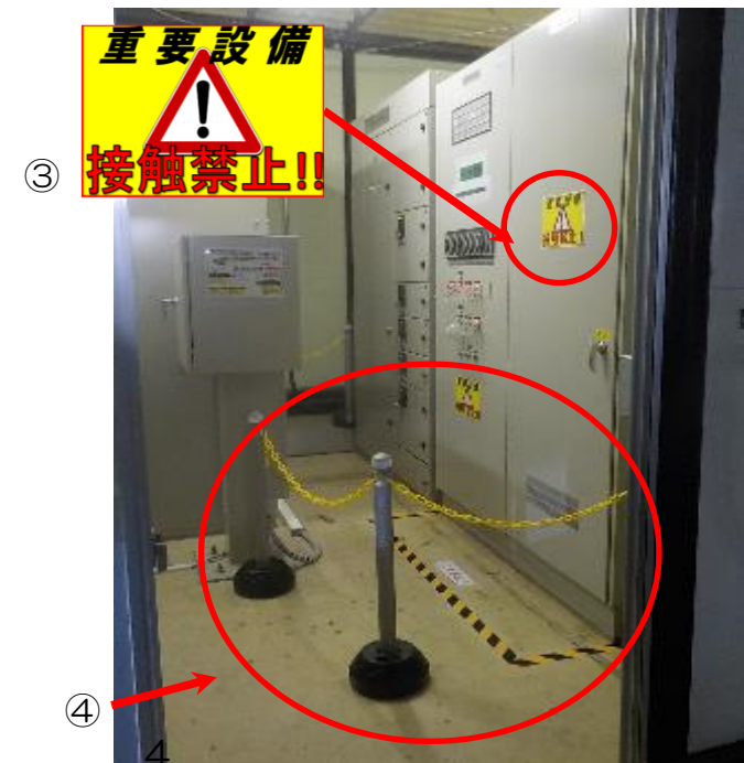
③接触禁止表示の設置
