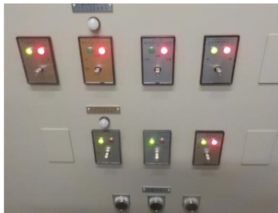
②操作スイッチレバーの取外し
