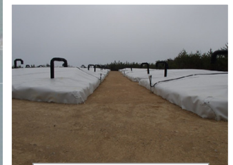
伐採木一時保管槽
