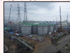
H1東エリア解体開始時の様子
