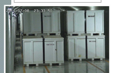
固体廃棄物貯蔵庫
