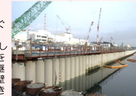
海側遮水壁 鋼管矢板打設完了状況
