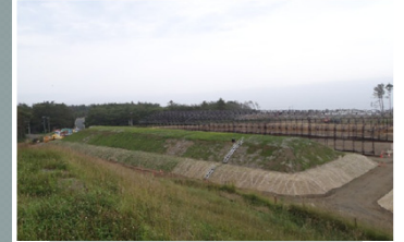
覆土式一時保管施設
