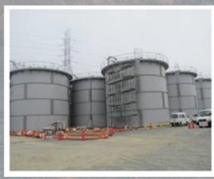
タンクの設置状況
