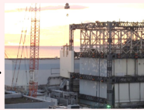
<壁パネル取り外し状況>
