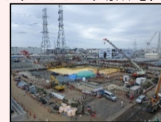
H1東エリア解体後の様子
