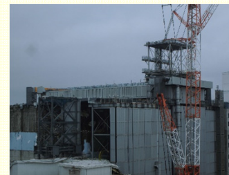
<ドーム屋根設置作業状況(スライド架台設置)>
