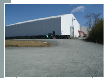
瓦礫保管テント
