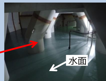
打設後のS/C内の状況
