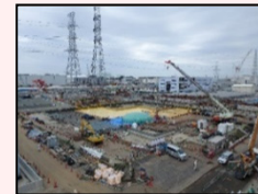
H1東エリア解体後の様子
