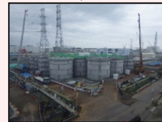
H1東エリア解体開始時の様子
