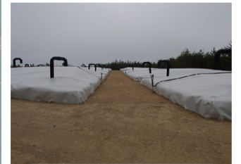
伐採木一時保管槽
