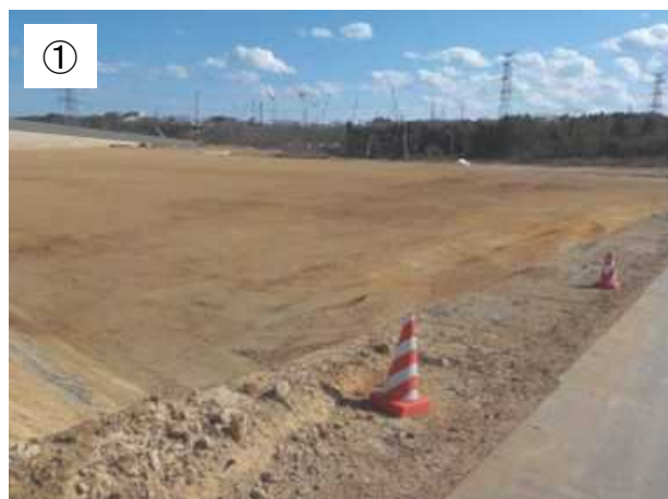
現場状況写真
