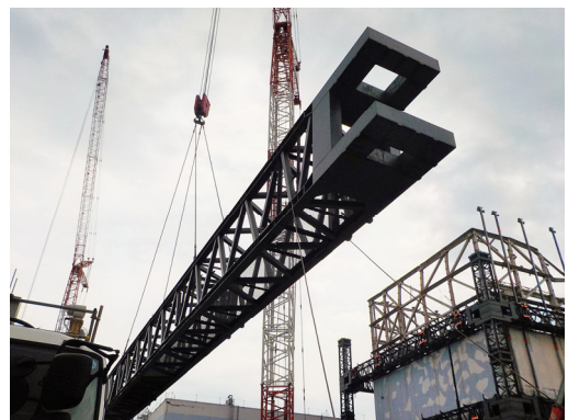
柱・梁取り外し (中段南梁)
