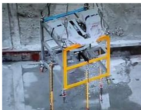
クレーンで吊り上げ架台を遠隔操作している状況
