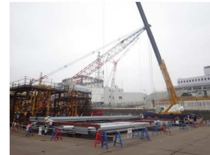
写真⑤ 地上での地組状況
