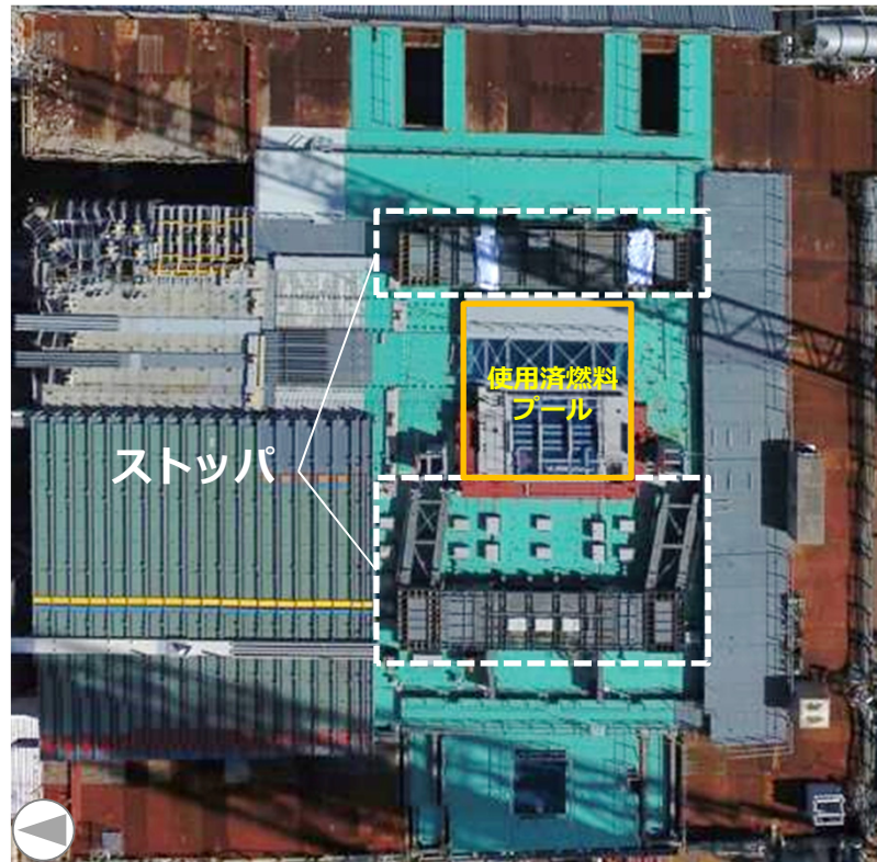
ストッパ吊り込み完了（撮影日2017年2月13日）
