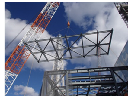
写真④ 前室鉄骨設置状況
