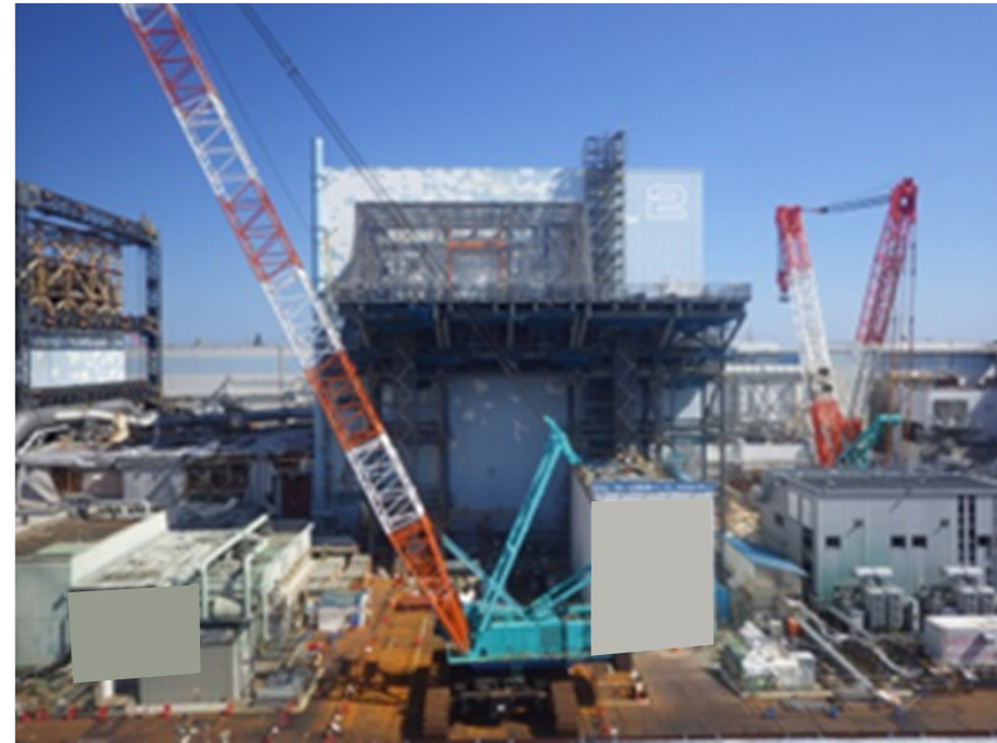
写真③ 2号機原子炉建屋 前室設置状況（全景、2017.3.11撮影）
