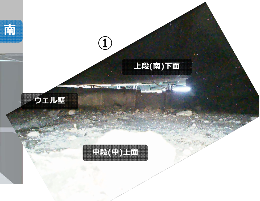
中段北側より撮影(北⇒南)
