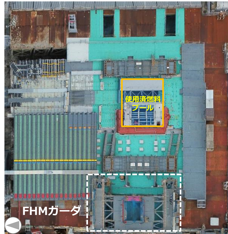
FHMガーダ設置作業中（撮影日2017年3月13日）
