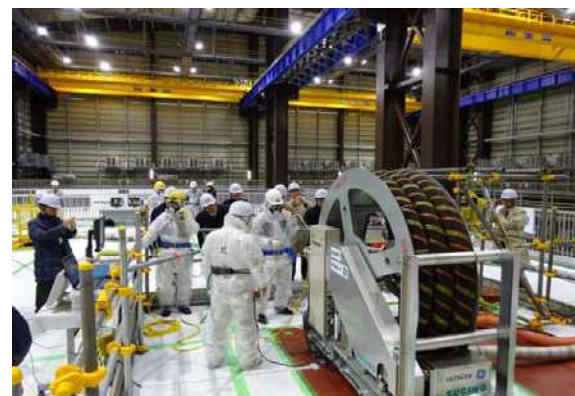
写真 S/C脚部補強施工性確認試験 (平成28年11月30日撮影)
