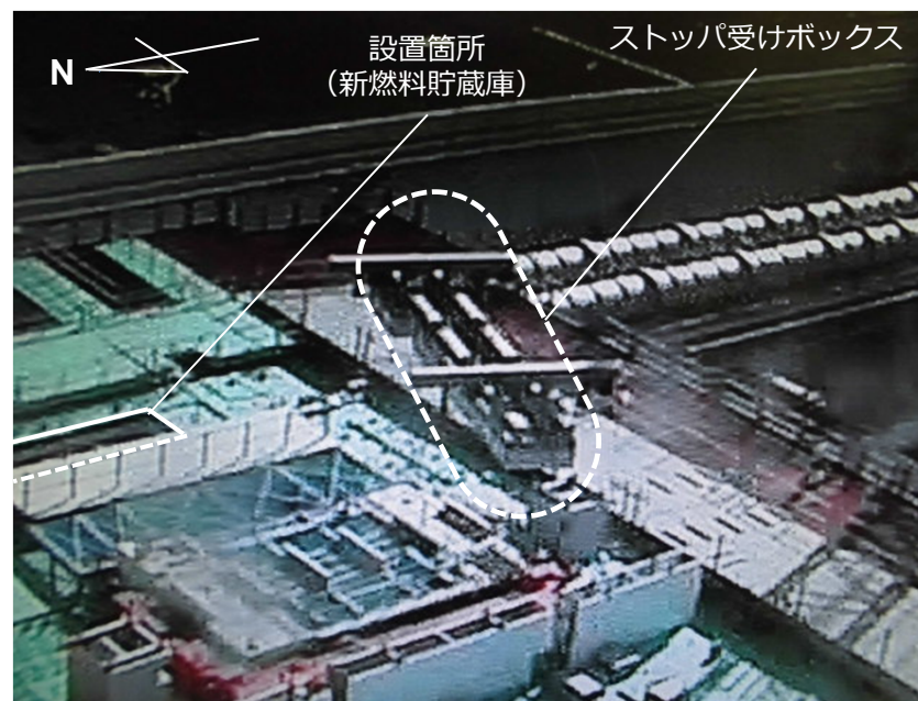
ストッパ受けボックス設置状況（撮影日2017年1月17日）
