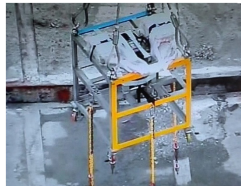
クレーンによる遠隔操作状況
