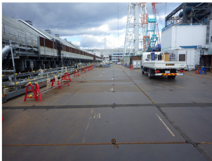
写真① 西側路盤整備完了
