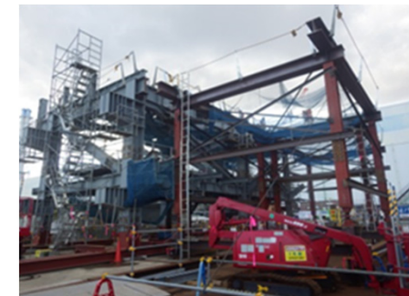
写真⑤ 地上での地組状況
