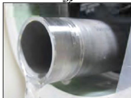
配管シール面外観確認
