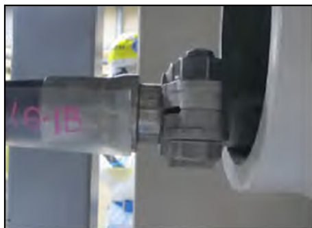
【分解前】配管芯ずれ確認
