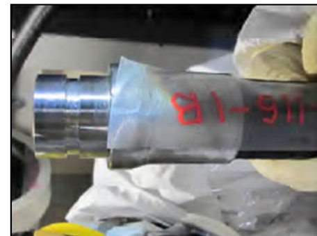
配管シール面外観確認
