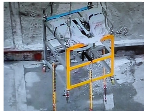
クレーンによる遠隔操作状況
