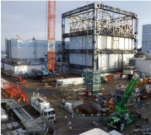
全景(北西面) 撮影：H28.12.19
