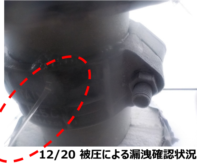
12/19 ブライン漏洩状況 (漏洩元付近被覆材継目)
