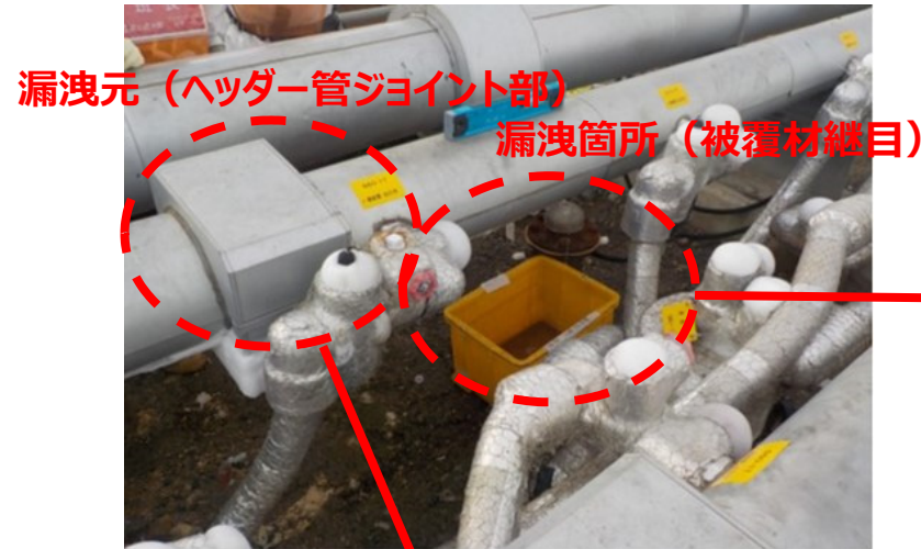
12/19 漏洩箇所 (凍結管670-1T付近)
