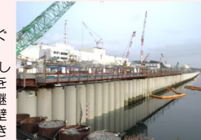
海側遮水壁 鋼管矢板打設完了状況
