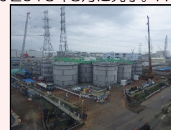
H1東エリア解体開始時の様子
