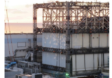
(1号機建屋カバー壁パネル取外状況)
