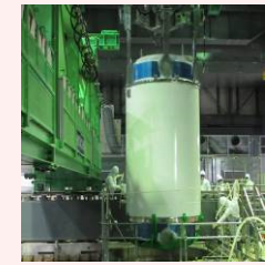
燃料取り出し状況
