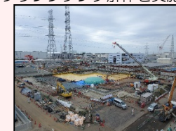
H1東エリア解体後の様子
