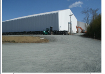
瓦礫保管テント
