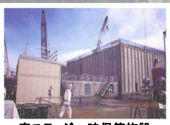
廃スラッジ一時保管施設
