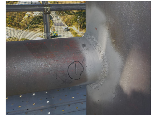
補修後（水平材）
