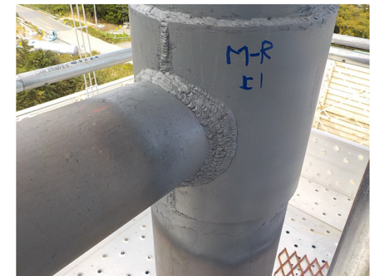
補修後（水平材）
