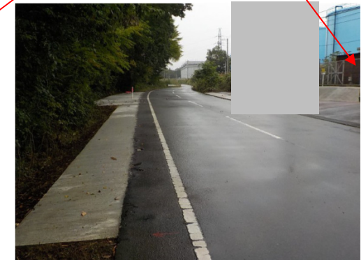
道路の西側路肩部分
