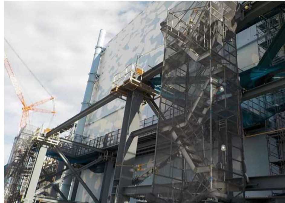
写真⑤ 2号機原子炉建屋 西側構台建方状況
