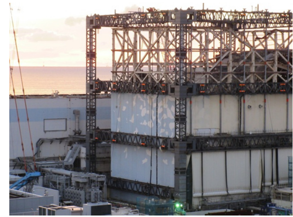
取り外し後建屋状況
