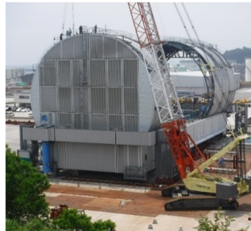
ドーム屋根大型ユニットの設置訓練状況写真（小名浜港）
