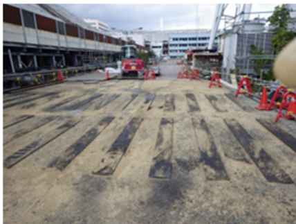
写真① 路盤碎石敷設完了
