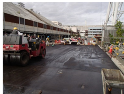
写真② アスファルト舗装中
