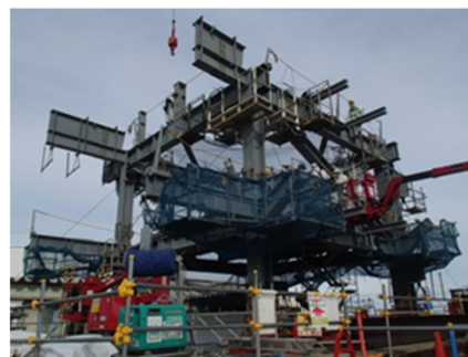
写真③ 5段目ユニット地組
