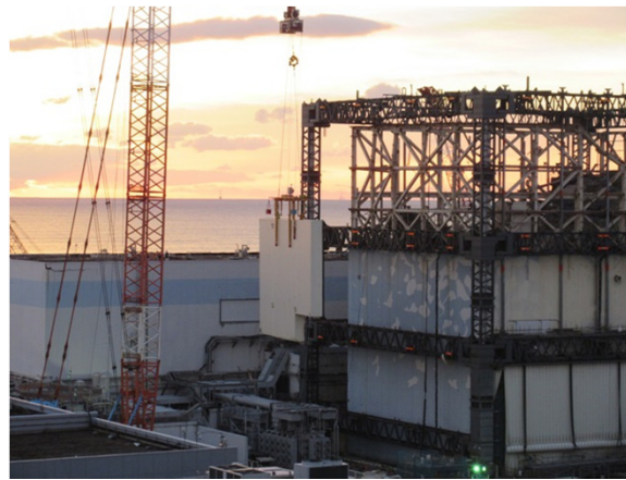
壁パネル吊り下し状況
