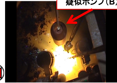
疑似ポンプ (B) 投入作業状況
