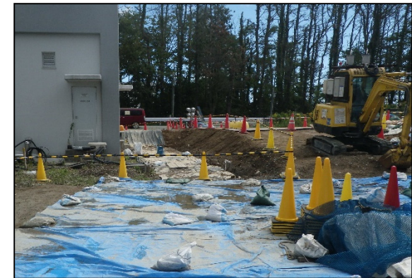
過去の汚染土回収状況
