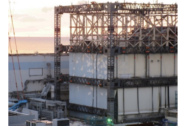
(1号機建屋カバー壁パネル取外状況)
