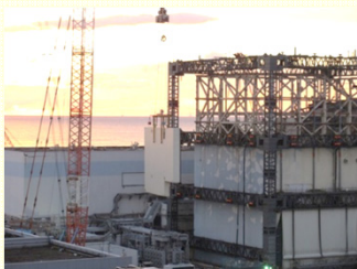
<壁パネル取外し状況>
