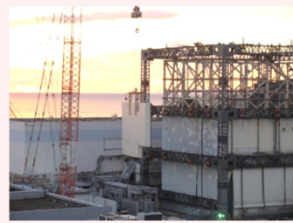
<壁パネル取り外し状況>
