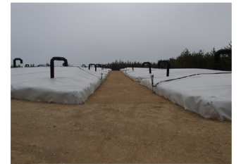
伐採木一時保管槽
