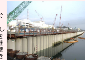
海側遮水壁 鋼管矢板打設完了状況
