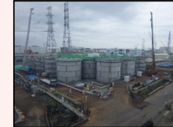
H1東エリア解体開始時の様子
