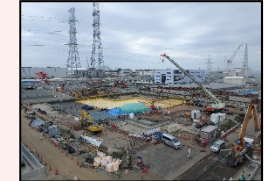
H1東エリア解体後の様子
