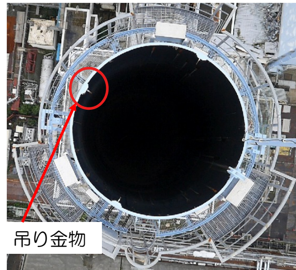
排気筒頂部状況
