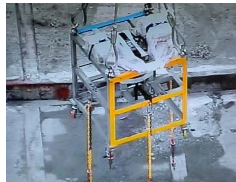
クレーンによる遠隔操作状況
