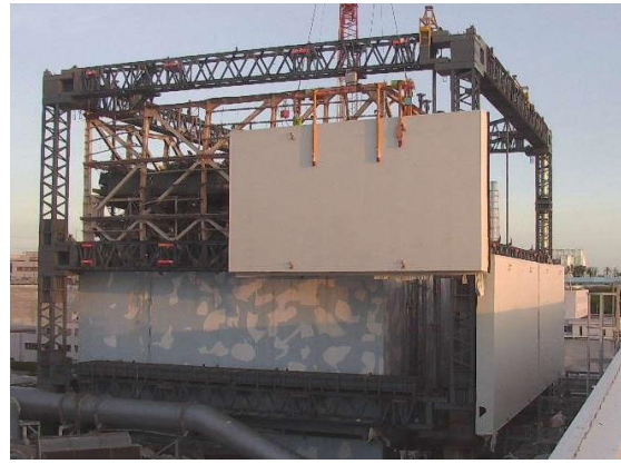
壁パネル取り外し状況（南面） 撮影：H28.10.22
