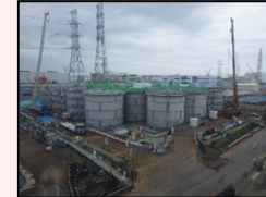
H1東エリア解体開始時の様子
