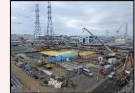
H1東エリア解体後の様子
