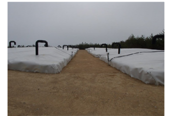
伐採木一時保管槽
