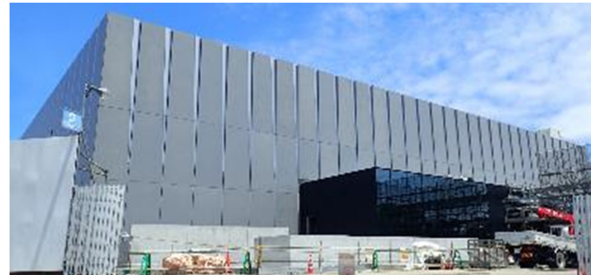
新事務本館（建設中）
